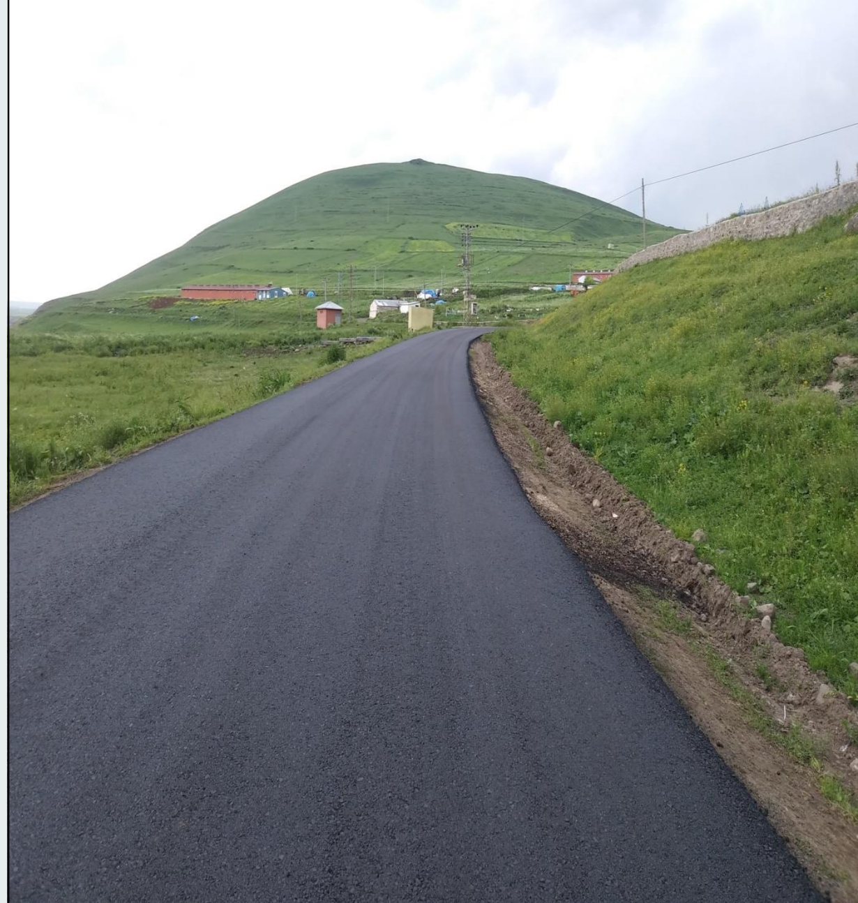
MERKEZ TAŞLIDERE KÖYÜ BSK YAPIMI (KÖYDES)
